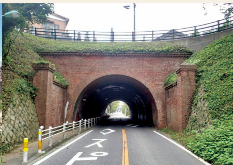
2014 年度選奨土木遺産（千葉県 成宗電車第二トンネル）
