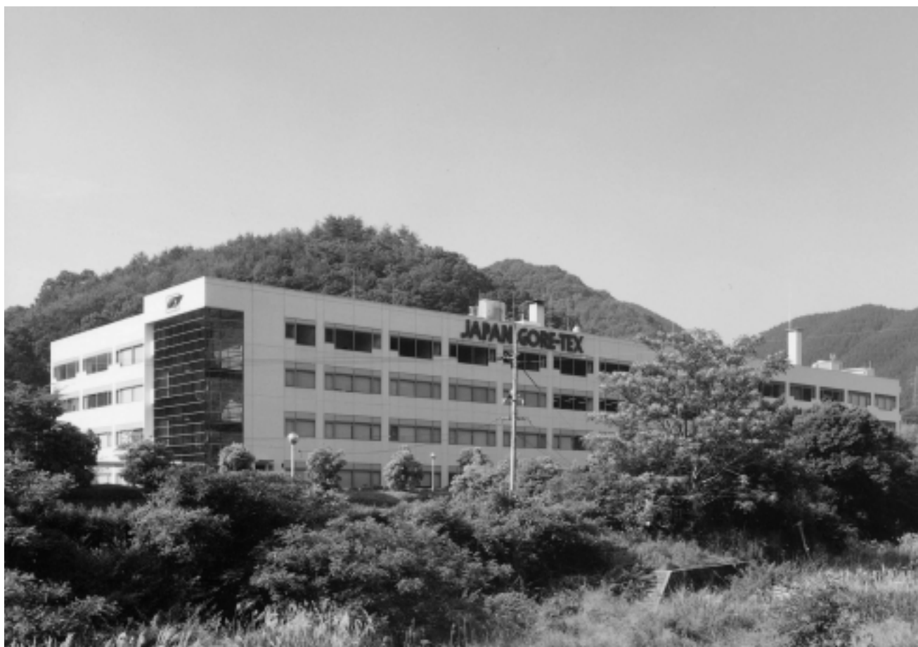
写真 - 1 建物外観
