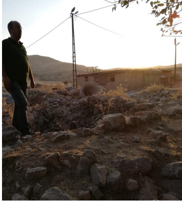
Hertevin köyünde yıkık Keldani evleri
