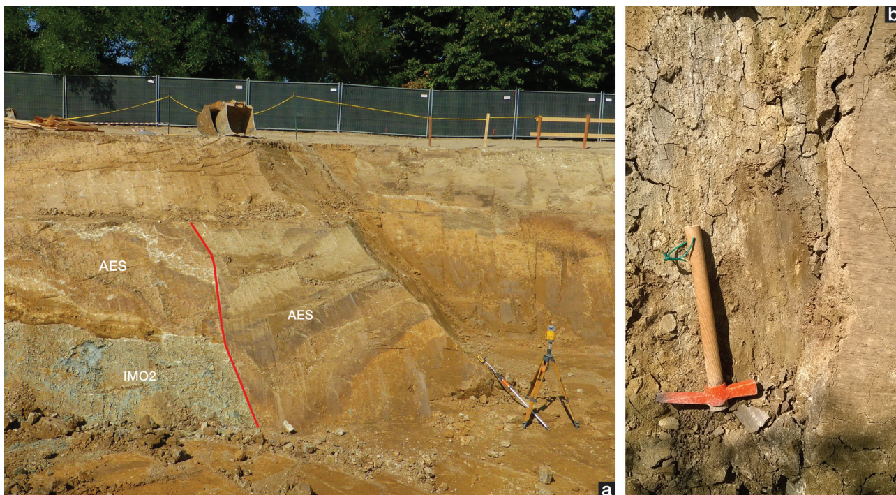
Figura 4.29: deformazioni mesoscopiche a carico delle Sabbie di Imola (membro IMO 2 ) e del Sintema Emiliano-Romagnolo Superiore osservate in uno scavo a Varignana.
