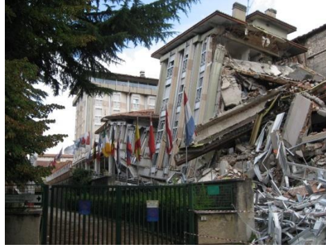
図3 1階駐車場部分がつぶれたマンション 図4 1階が坐屈したホテル
