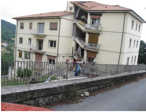
図3 1階駐車場部分がつぶれたマンション 図4 1階が坐屈したホテル
