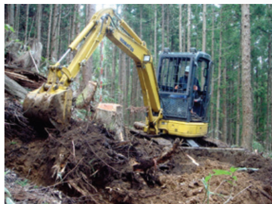
作業路の作設
