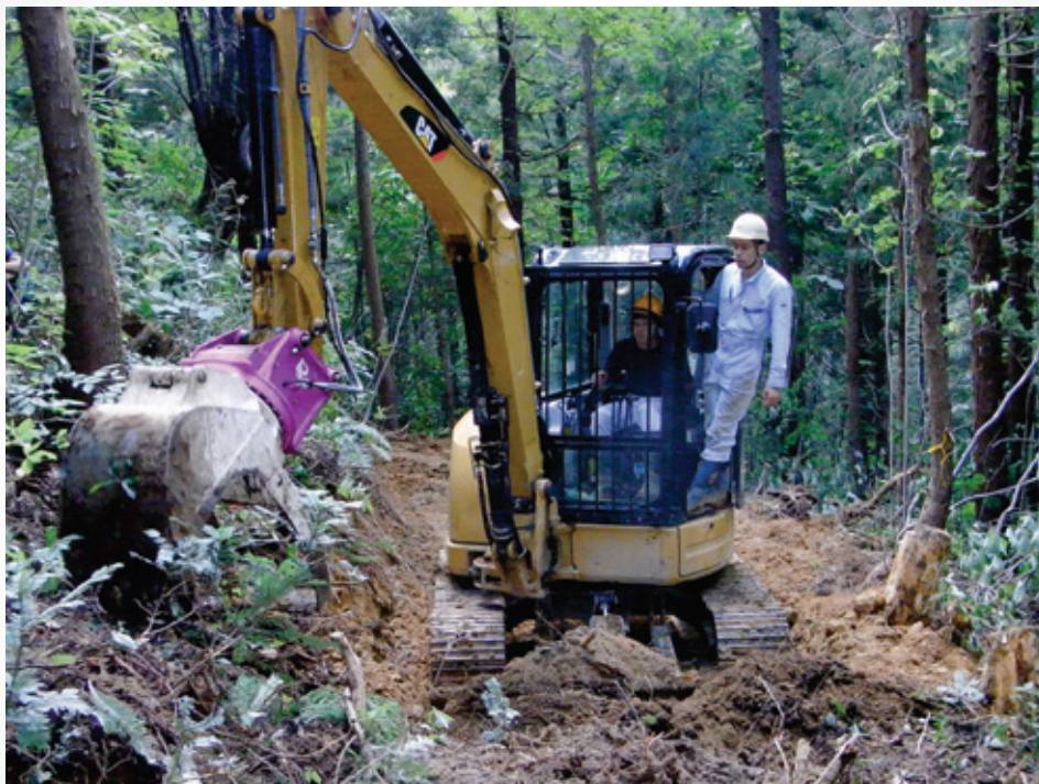
作業路の作設
