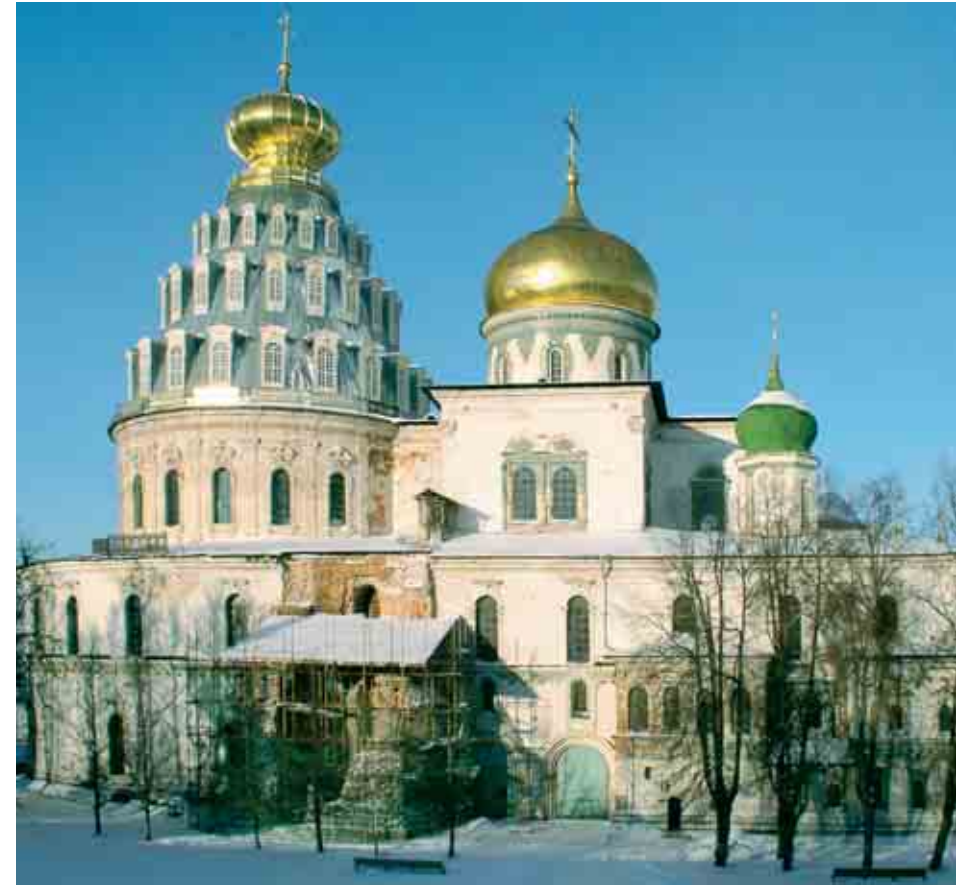
Храм Воскресения Христова в Новом Иерусалиме. Южный фасад. Современный вид
