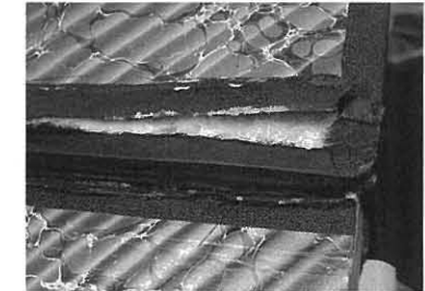
写真2.5.7 ノドのクロスの補強
