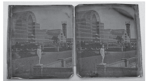
写真5.6 解体 周辺の乳白色の変色
