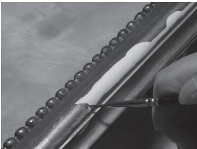
写真2.1.14 砥の粉下地塗布作業
