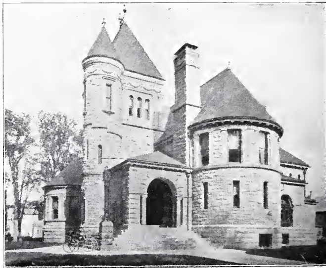
Obr. 13. Průčelí veřejné knihovny ve Fairhavenu.
