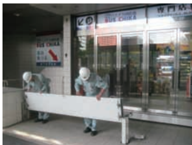
株福岡交通センターによる止水板設置訓練
