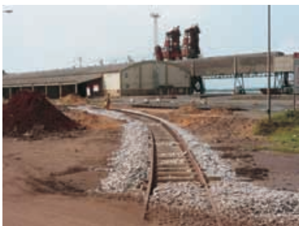
写真-33 マプト港では埠頭への引き込み線の軌道工事が行なわれている。(2012年12月7日)
