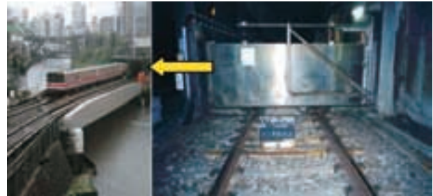
図-5 坑口防水ゲート
