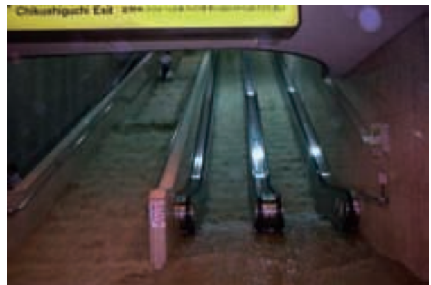
地下鉄博多駅に流れ込む濁流
