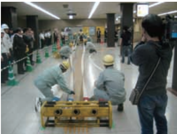
可搬式ポンプ設置訓練
