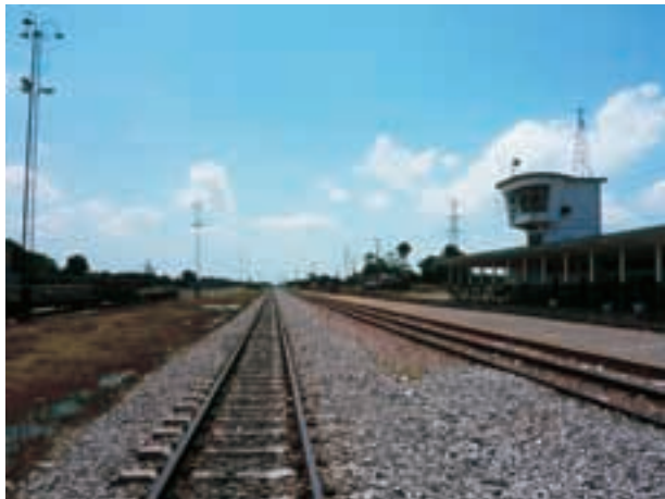
写真-36 マプト近郊にあるマシャバ駅。駅舎の屋根の上には信号扱い所がある。(2012年12月7日)
