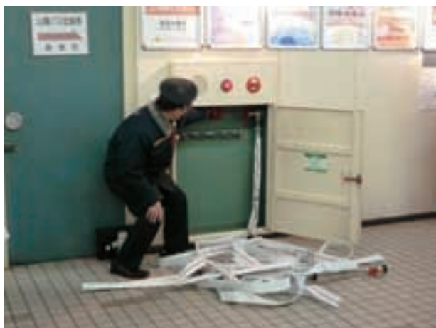
消火栓の取扱い説明
