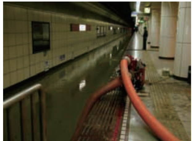
冠水した地下鉄博多駅ホーム
