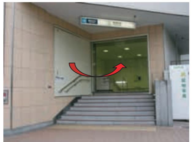
図-2 駅出入口の嵩上げと防水扉
