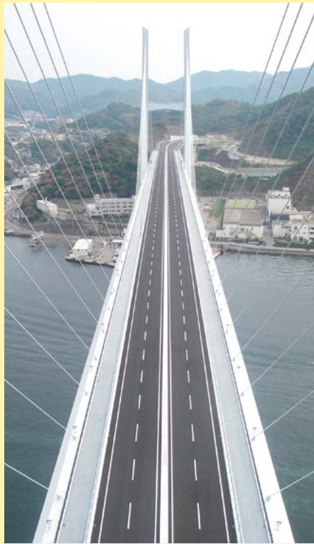
女神大橋の道路新設工事
