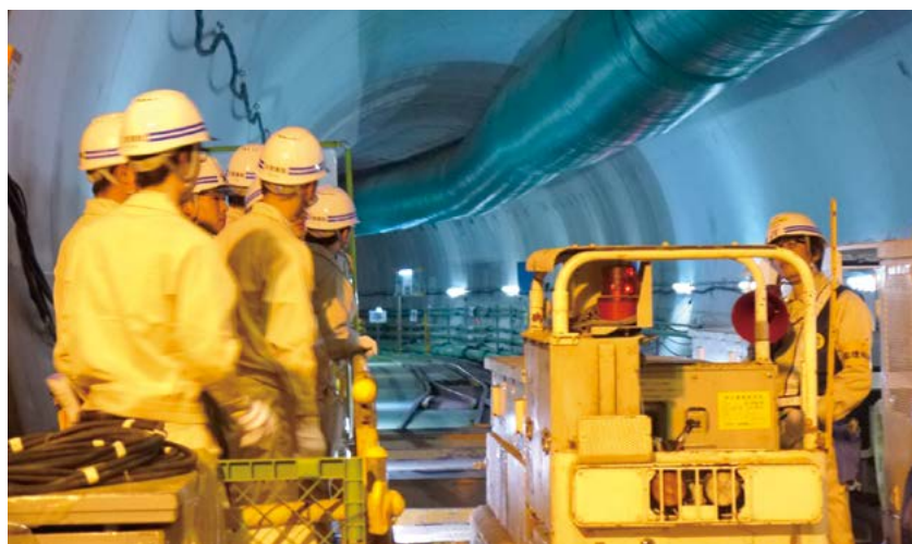
平成29年 江東幹線 現場見学
