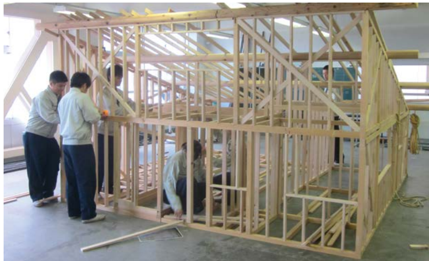
吉村順三氏設計の「軽井沢の山荘」の軸組模型を作成。2階の木造部を1/2の縮尺にて再現
