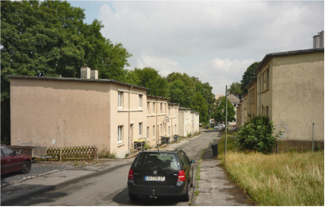
1 Iserlohn, Schlieperblock. Siedlung mit Notwohnungen, erbaut 1928–1936. Meisenweg von 1925 bis 1930. 2010.
