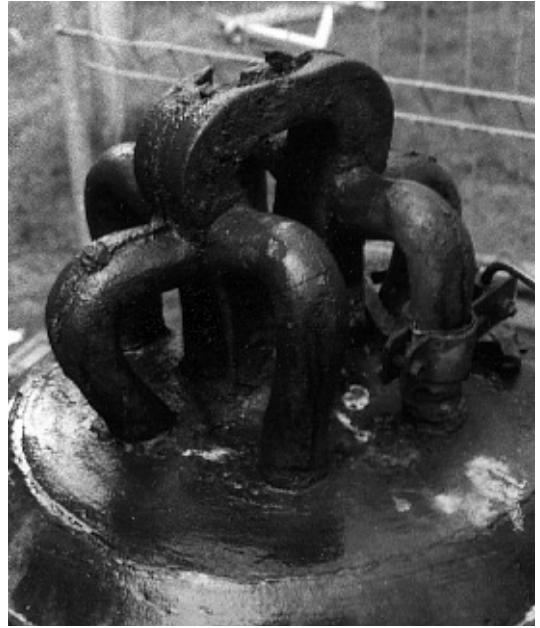
5 Beschädigte Krone der dritten Glocke (13. Jh.). Am linken der beiden paarigen Henkel ist der Riss erkennbar.
