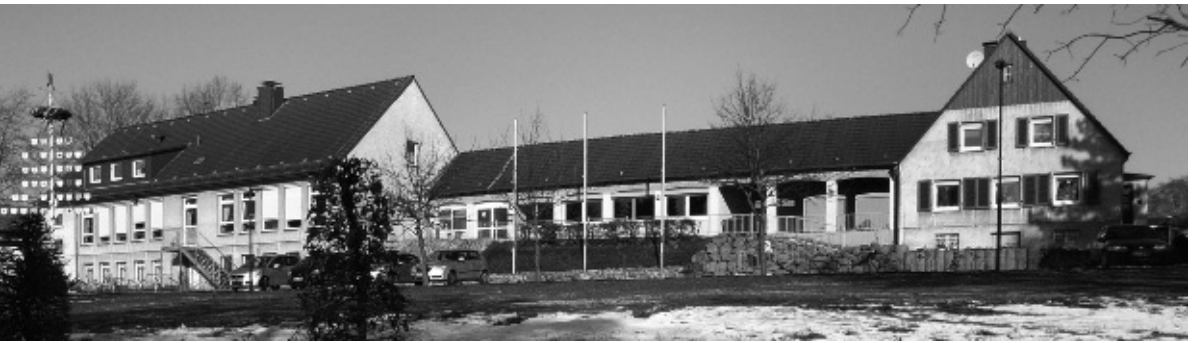
16 Fröndenberg-Warmen (Kreis Unna); Schulgebäude (links) und Hausmeisterwohnung (rechts) von 1950–51, verbunden durch eine ursprünglich neunjochig-offene Pausenhalle. 2009.
