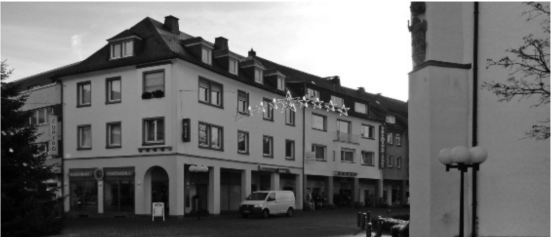
12 Meschede (Hochsauerlandkreis), Ostseite der Ruhrstraße nach Kriegszerstörung der Vorgängerbebauung gegenüber der Kirche St. Walburga. 2009.
