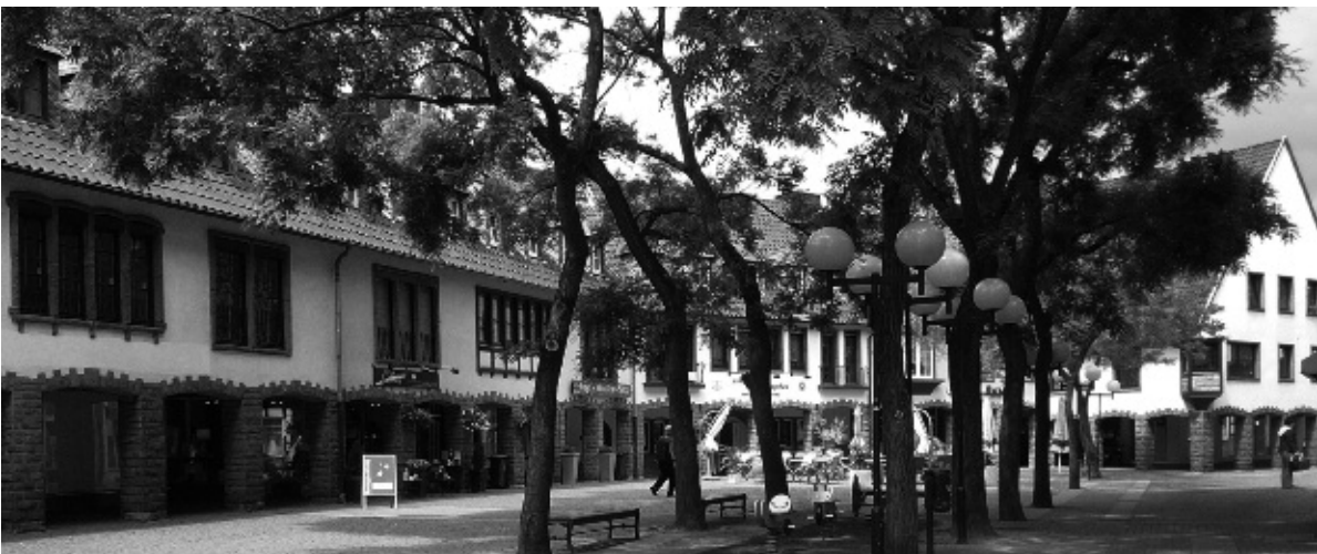
10 Hattingen (Kreis Ennepe-Ruhr), Krämersdorf von 1946–53 nach Kriegszerstörung der Vorgängerbebauung, Stadtbaurat Ulrich. 2010.
