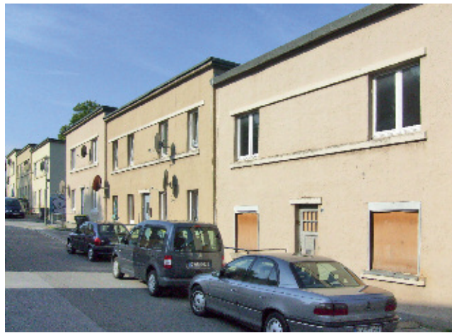
3 Iserlohn, Schlieperblock. Siedlung mit Notwohnungen, erbaut 1928–1936. Meisenweg. 2010.
