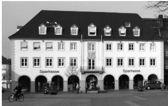
4 Hamm, Sparkasse von 1951 an Stelle des kriegszerstörten Rathauses von 1532; allerdings wurde gegenüber dem Vorgängerbau ein Geschoss aufgesetzt, auf das barocke Mansarddach verzichtet und die Zahl der Bögen von acht auf neun erhöht. 2010.
