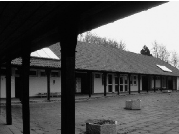
17 Lübecke (Kreis Minden-Lübbecke), Hochbauten des Freibades von 1952. 2004.
