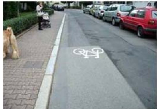
生活道路では自転車マークのみ標示
