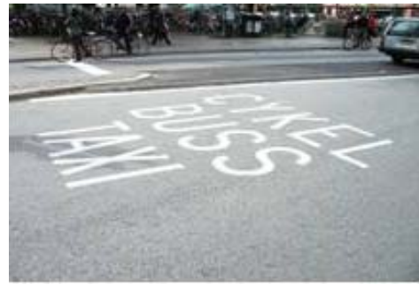
共用レーンにおける自転車優先の標示
