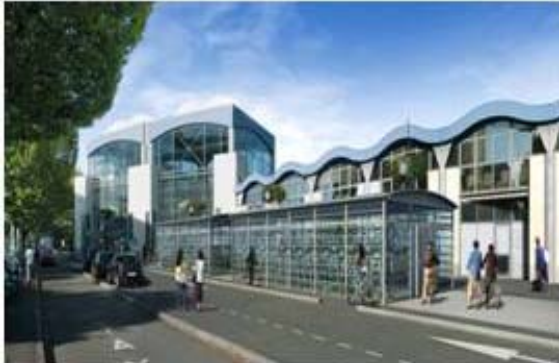
ナント中央駅前に建設中の駐輪場 （駅から30Mという近距離に設置）
