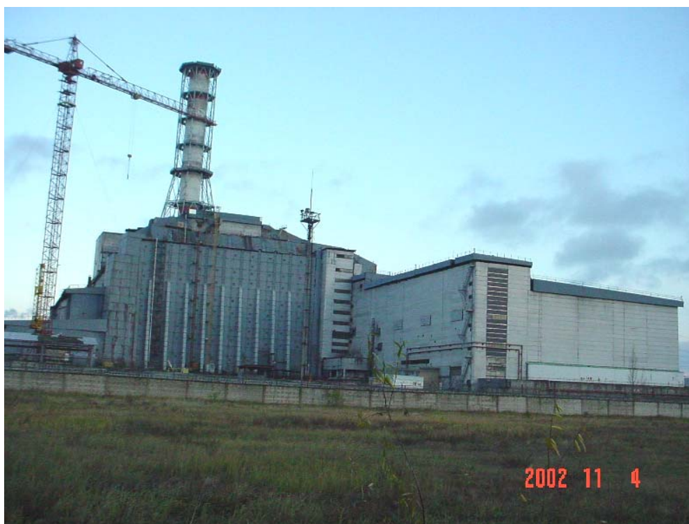
破壊された4号炉を覆う石棺(2002年11月)
