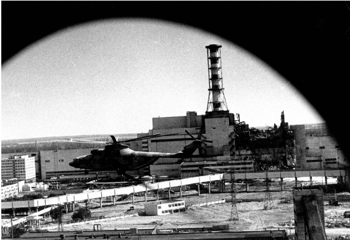
事故直後の数日間、日が照っている間中、大型の軍用ヘリコプターがチェルノブイリ原発周辺を飛び回り、原発敷地の全体に特殊な粘着性の溶液を散布した。この溶液は、敷地内のいたるところを覆っていた放射性的ほこりを吸着した。 撮影・イーゴリ・コスティン
