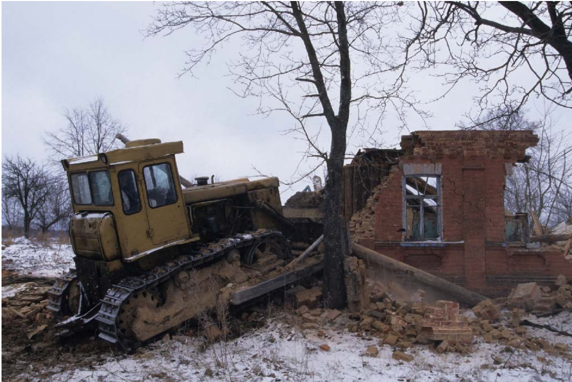
汚染された家を壊して、地中に埋める作業をするブルドーザー。ベラルーシのオチェソルドニャ村。(1999年)
