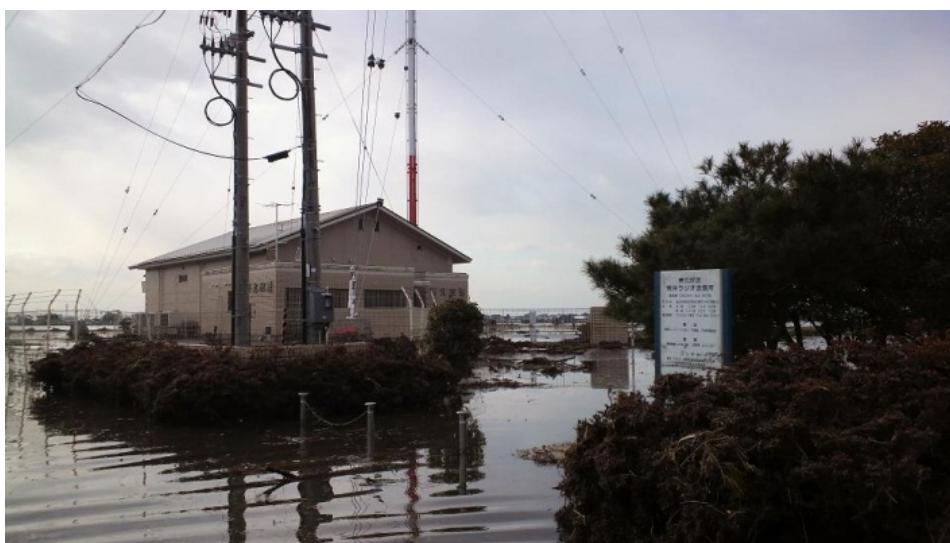
津波による被害を受けた東北放送荒井ラジオ送信所（海岸部から約2.4km、海拔約2m） （「放送ネットワークの強靱化に関する検討会」民間放送事業者発表資料より）
