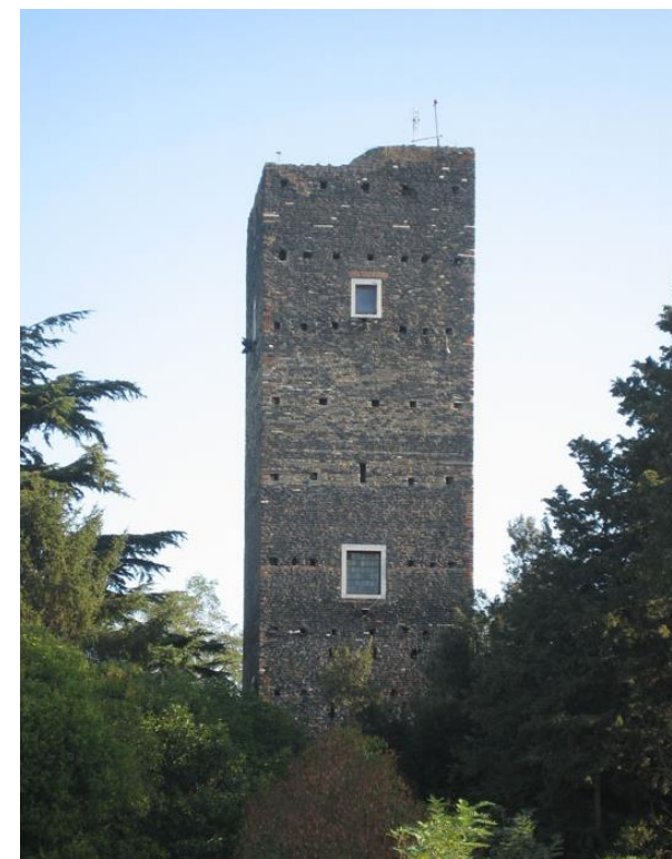
Torre delle Cornacchie
