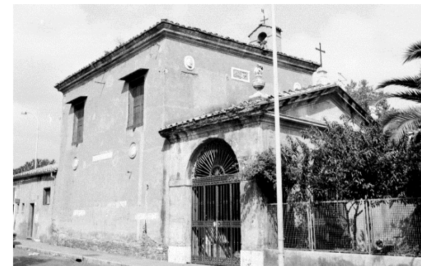
Chiesa dei Santi Isidoro ed Eurosia in una fotografia del 1977.
