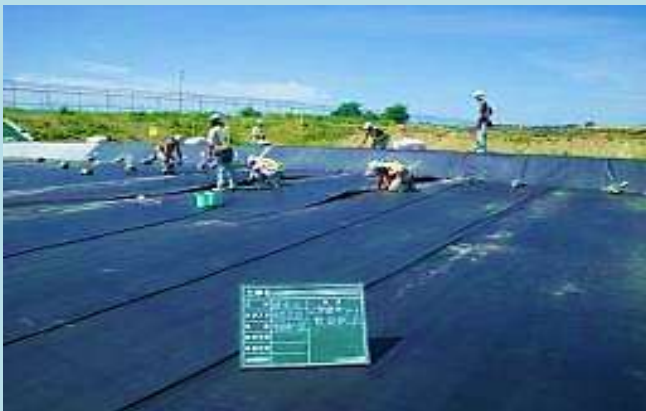
遮水シート工事
