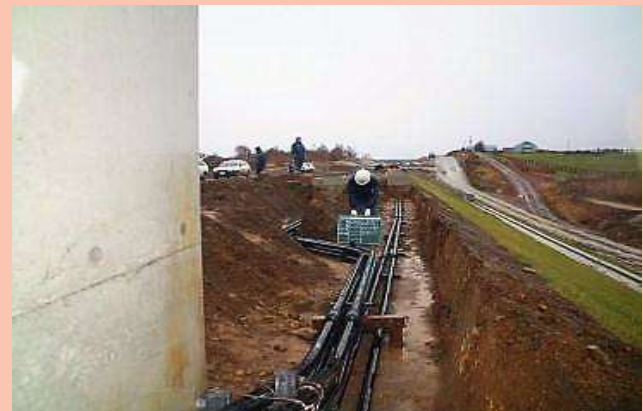
電気通信管工事
