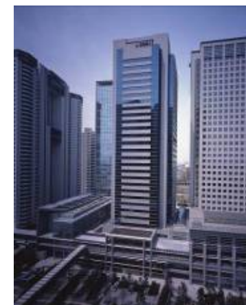
本社ビル(品川) [撮影 木田勝久/FOTOTECA]
