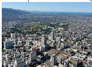
札幌駅北口地区 地域冷暖房施設
