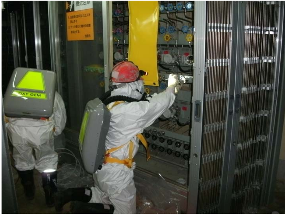
図3 1号機 原子炉水位計校正作業の様子
