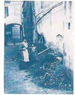
Entrada dels safareigs del carrer de Còdols. La fotografia il·lustra, juntament amb d'altres igualment expressives, un informe de l'estat sanitari de la Ciutat Vella el 1909. Comissió de Governació, D-1.329. Foto: Institut Municipal d'Història de la Ciutat, Barcelona.
