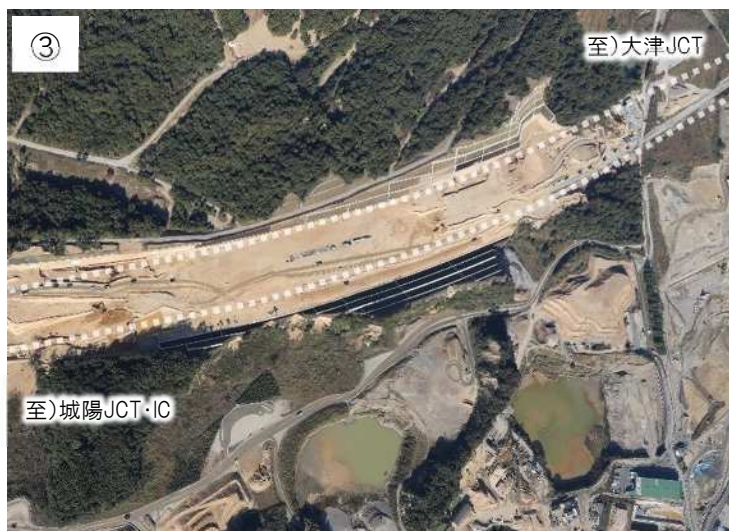
城陽市域土工部の整備状況
