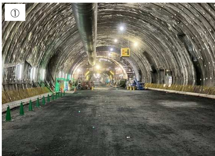
宇治田原トンネルの整備状況
