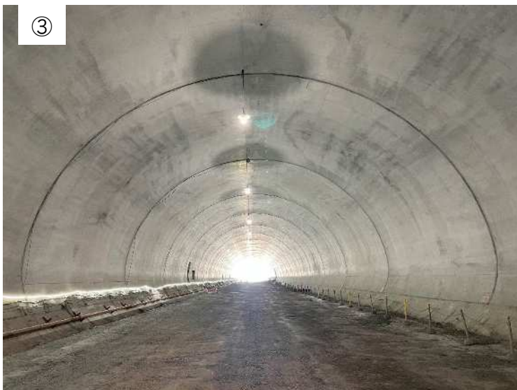
大津大石トンネルの整備状況
