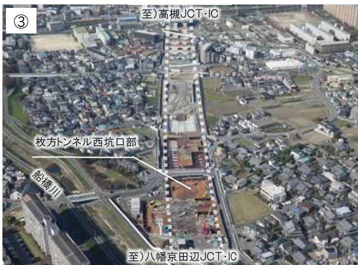
枚方トンネル西坑口部の整備状況
