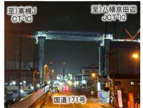
国道171号架設後
