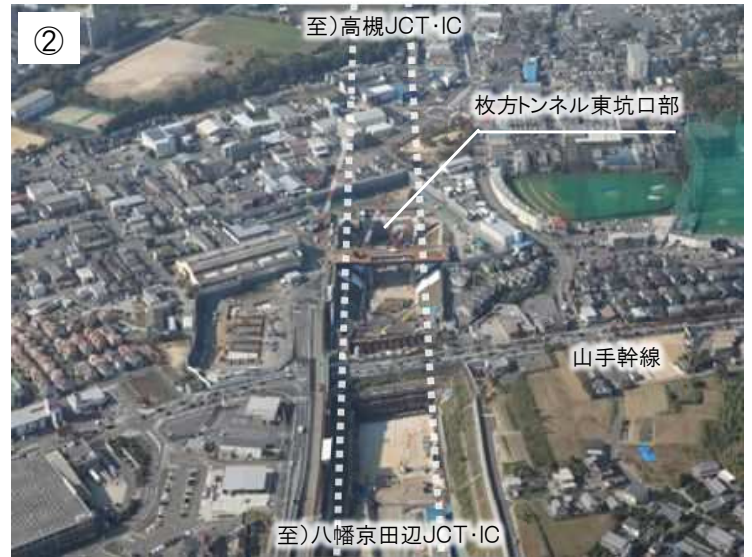
枚方トンネル東坑口部の整備状況
