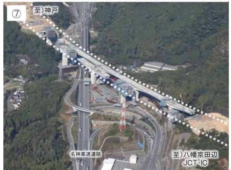
高槻JCT・IC付近の整備状況
