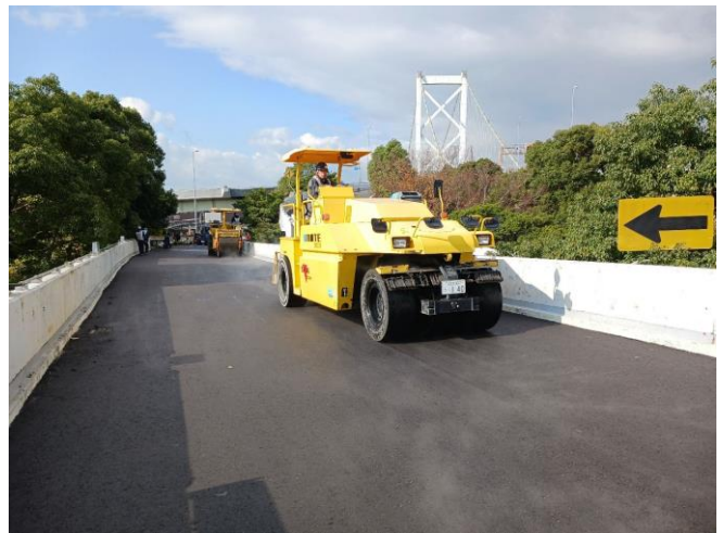
<めかりPA内 舗装補修工事状況>
