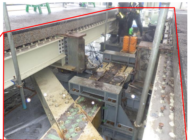
< 縦桁・横桁一括撤去状況 >
