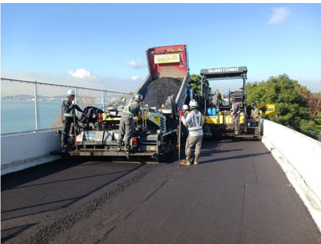
<めかりPA内 舗装補修工事状況>
