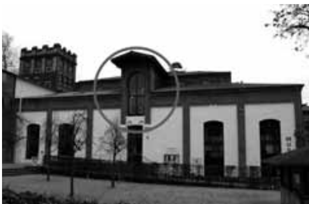
Stadtarchiv Pritzwalk. Bausubstanz durch Fenster im Bereich der Anmeldung ersetzt. (Foto: J. Tempelhoff, 01.12.2011)
