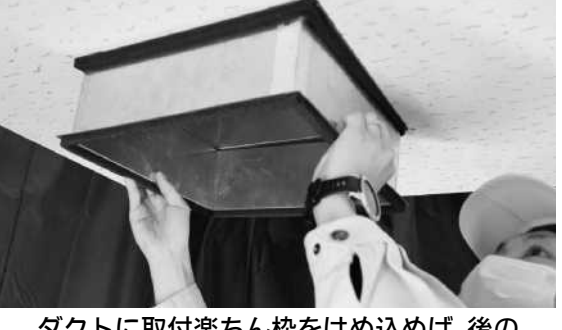
ダクトに取付楽ちゃん枠をはめ込めば、後の作業は文字通り「楽ちゃん」に
