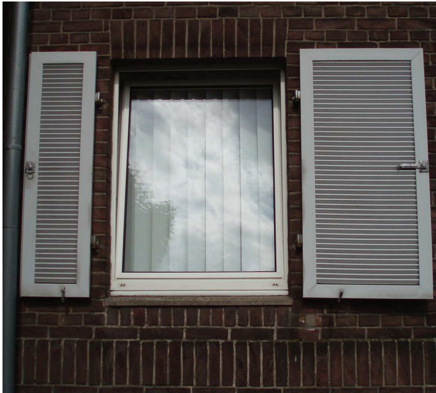
Abbildung 12: Neues Fenster mit Isolierverglasung
