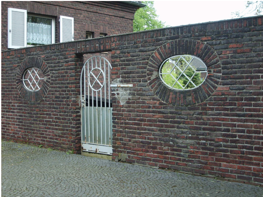
Abbildung 18: Fassadenunterbrechung mit Mauer Ter-Meer-Straße
