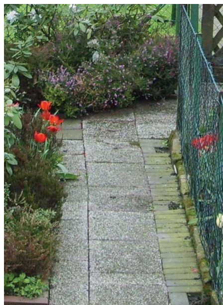
Abbildung 33: Plattenweg Ter-Meer-Straße Quelle: Eigene Aufnahmen 2009
