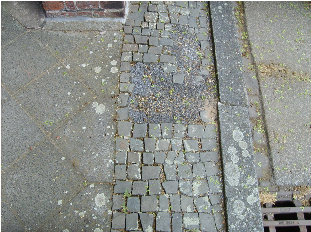
Abbildung 28: Bürgersteigbefestigung Ter-Meer-Platz, Platten mit Mosaikpflaster Quelle: Eigene Aufnahmen 2009
