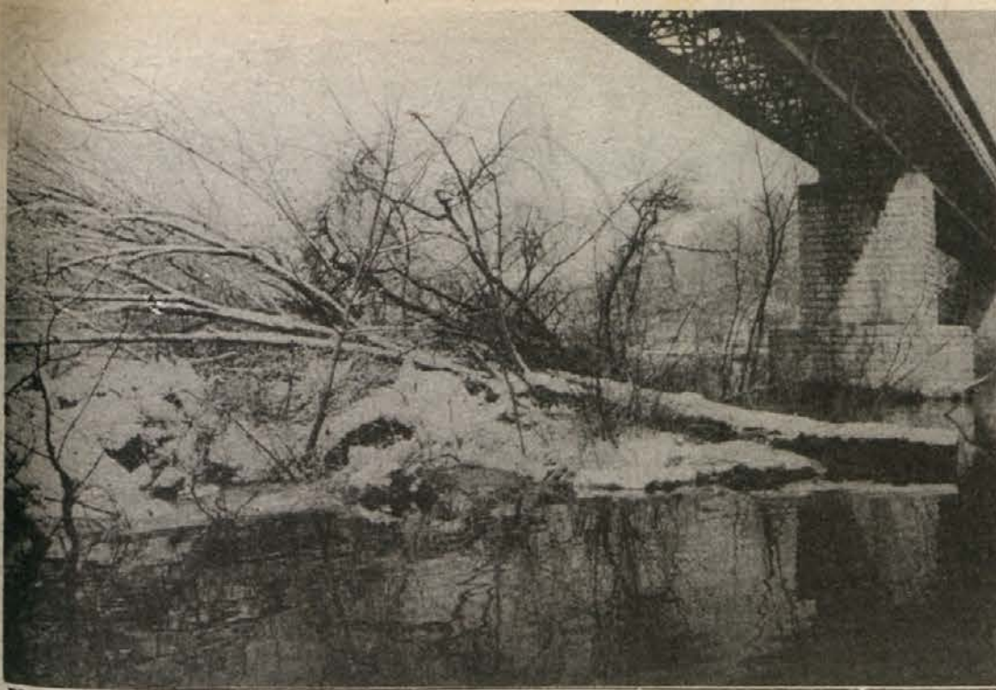
PLAZ ZOŽIL KRKO — Ob železniškem mostu, na nakdanjem odlagališču kremenčevega peska podjetja Kremen iz Novega mesta, je v petek zdrsnilo v Krko nekaj sto kubikov zemlje, ki so jo tja že nekaj let pridno dovažali kamioni z gradbišč novega zdravstvenega doma, teniškega igrišča, v zadnjem času pa tudi z gradbišča Ceste herojev. Po mnenju komisije, ki si je v ponedeljek ogledala plaz, je zemlja pričela drseti zaradi gladke osnove, ostankov nekdanjih bazenov kremenčevega peska. Velike škode ni, potrebno pa bo čimprej spraviti strugo reke Krke v prejšnje stanje. (Foto: J. Pavlin)
