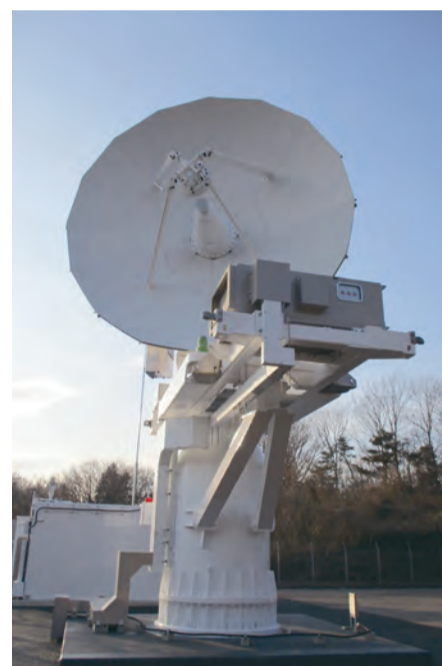
地球観測センターに設置されたKa帯アンテナ。写真の左下の地上に見えるのはコンテナ型のシェルタに実装された受信設備だ。
