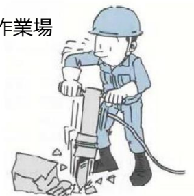
コンクリートブレーカーによる作業
