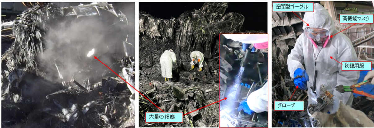
図 5 6 - 2 現場の状況（CFRP 粉塵、防護服）
