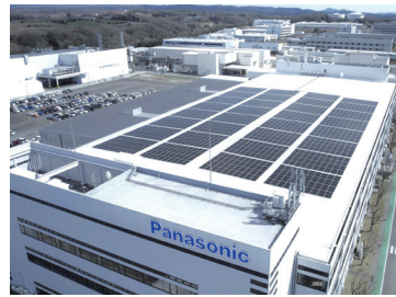
太陽光発電設備を導入
