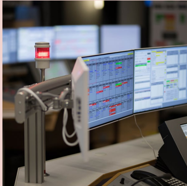
Ein Einsatzleitplatz in der Leitstelle der FwDus
