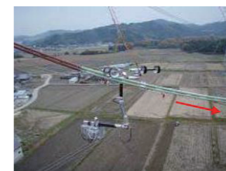
絶縁棒を使った電線乗り移り作業
