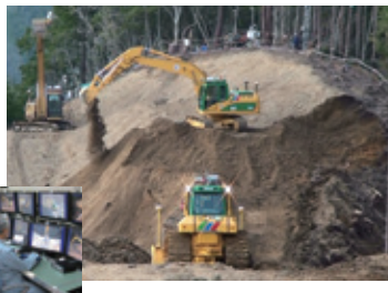
事例②：野迫川村北股地区の 斜面崩壊災害復旧工事
