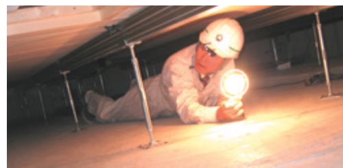
床下点検作業
