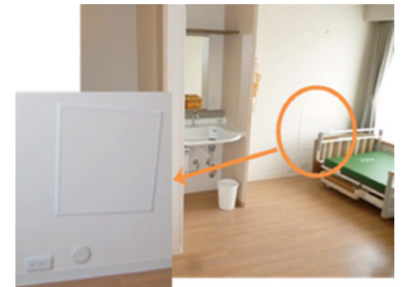
将来のベッドサイド水洗トイレを想定したプレ給排水管(壁内に隠す)
