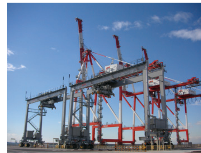
ガントリークレーン(奥) 遠隔自動RTG(手前)
