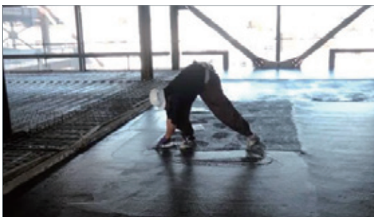
土間工による作業状況
