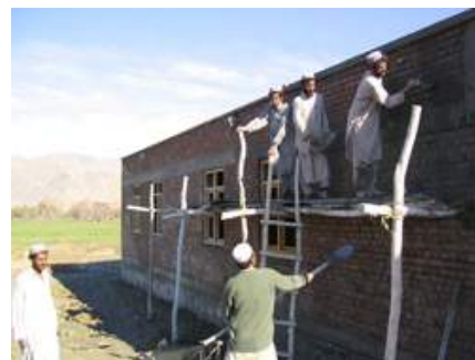
アフガニスタン プラスターに従事する作業員
