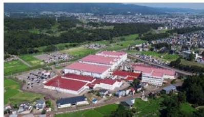
新井工場（新潟県妙高市）
