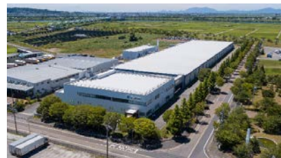
京ヶ瀬工場（新潟県阿賀野市）
