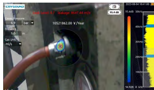
カメラによるエア漏れ検査
