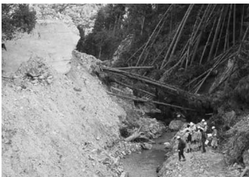
蝦夷倉川左岸に乗り上げた砂防堰堤
