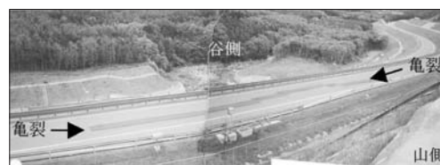
写真-1 切盛区間の亀裂補修状況(平成5年5~6月撮影)
