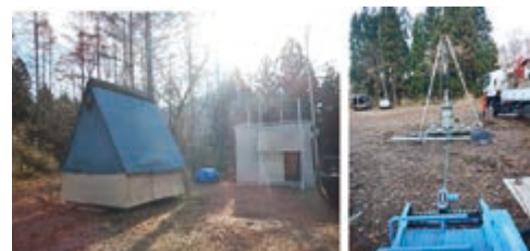
図1 坑内型微小地震計設置状況
