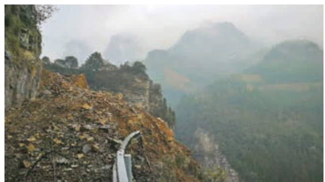
図9 図8の現場で発生したM5.7の誘発地震による大規模な山崩れ
