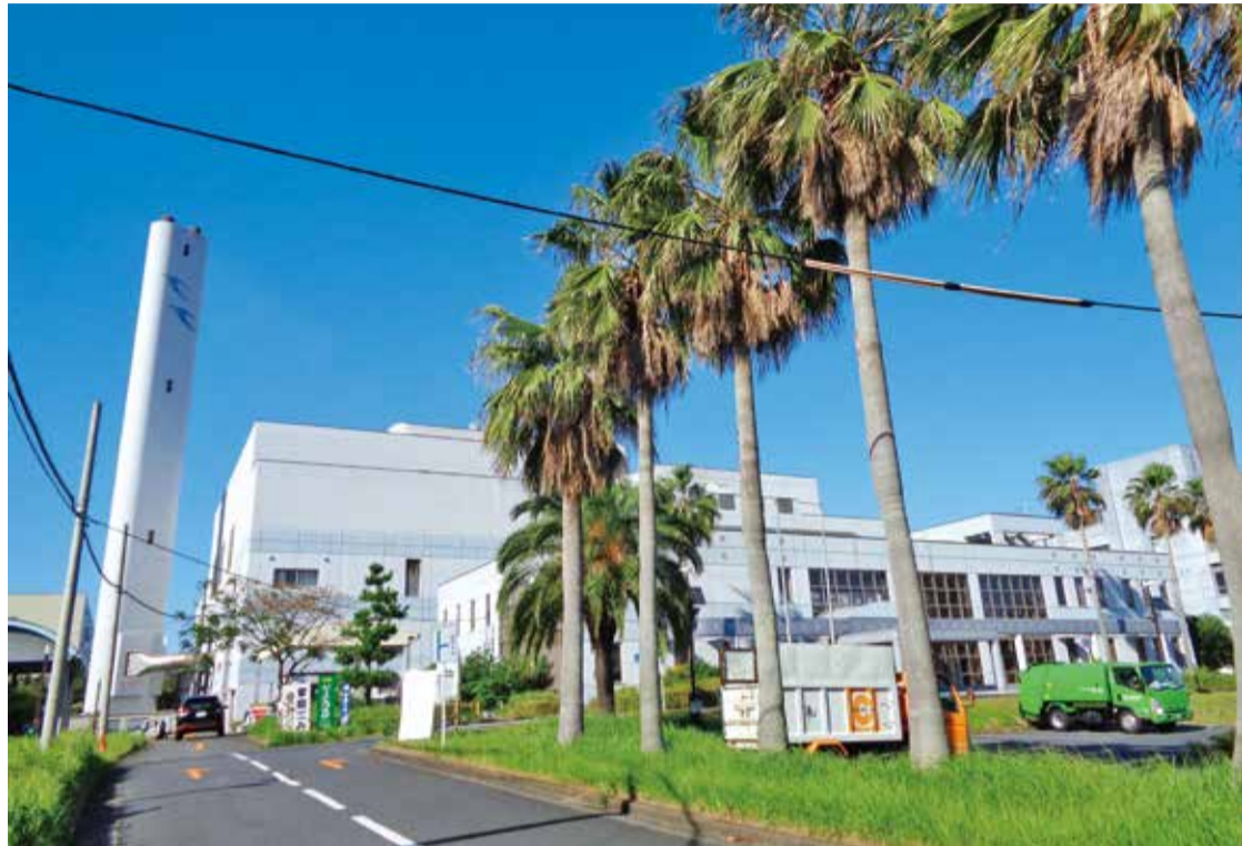
延命化工事がスタートするクリーンセンター
