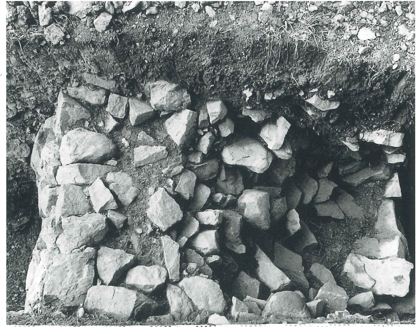
7 Kindelsberg. Blick von oben auf die Trockenmauer. Erkennbar sind rechts und links die beiden sauber gesetzten Schalen der Mauer und die dazwischen liegende Stein-Lehm-Schicht (Füllung). Auf beiden Seiten ist die sich nach unten verbreiternde Mauer zu erkennen.
