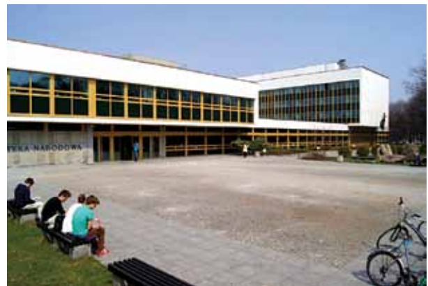
Wejście główne do Biblioteki Narodowej po remoncie i pracach termoizolacyjnych, lato 2013 roku
