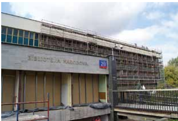
Prace remontowe siedziby głównej Biblioteki Narodowej przy al. Niepodległości 2013 roku
