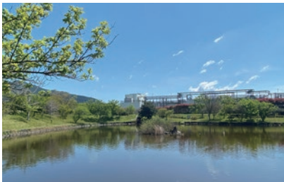
排水処理施設と調整池 (宮崎県えびの工場)
