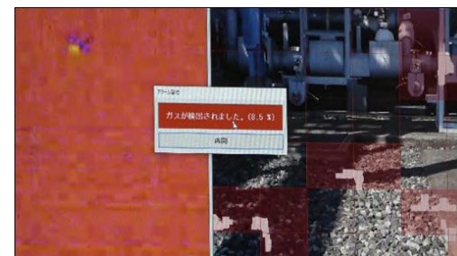
ガス漏れ検知画面
