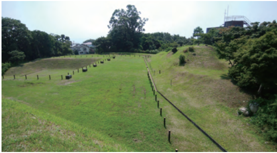
写真 4-9 新堀土塁旧アジアセンター地点(写真左の方形の穴の位置「遺構を避けて再建築できる範囲」がガイダンス施設の設置構想地点。写真右は土塁)
