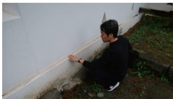
写真 8-6 台風 19 号（令和元年〔2019〕）による銅門の土塀剥落被害 （左：東面土塀漆喰剥落状況、 右：剥落・亀裂状況確認）
