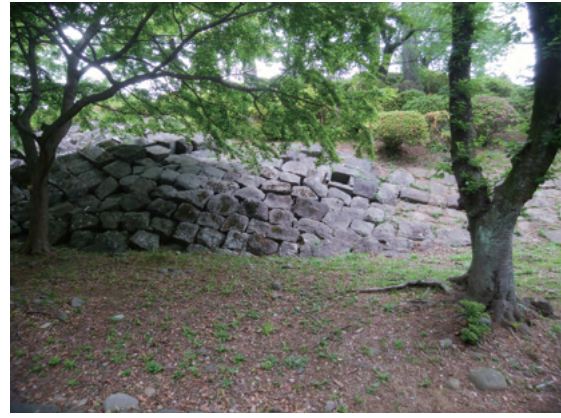
写真 8-9 本丸南堀付近（旧図書館北側）に残る関東大震災で滑落した石垣
