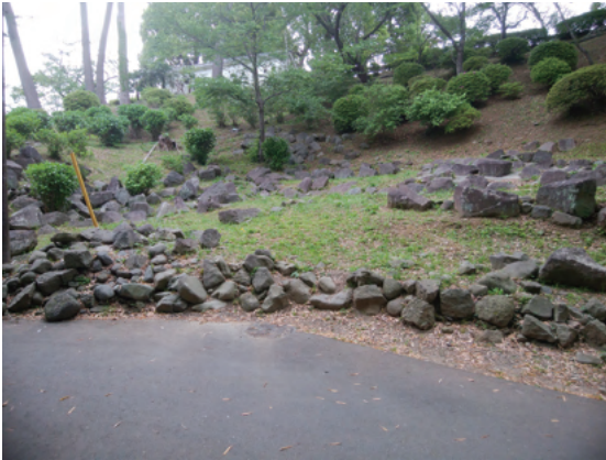
写真 8-9 本丸南堀付近（旧図書館北側）に残る関東大震災で滑落した石垣
