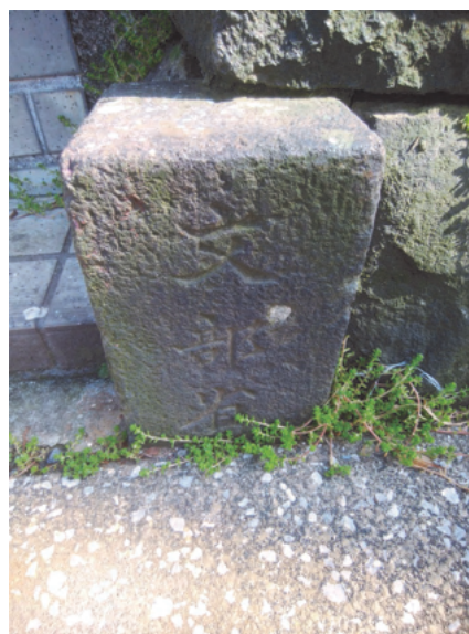
写真 8-4 史跡境界標 (大手口門北側櫓台)
