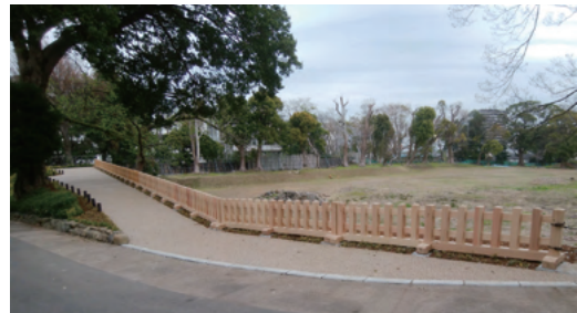
写真 4-5 整備が完了した御用米曲輪北西土塁(平成 30 年度)
