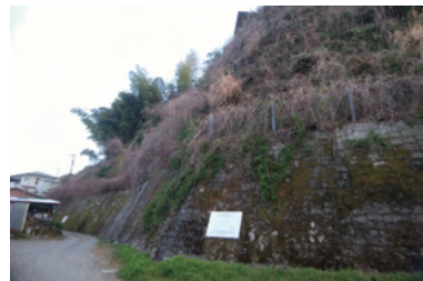
急傾斜地対策施設（谷津御鐘ノ台張出）
