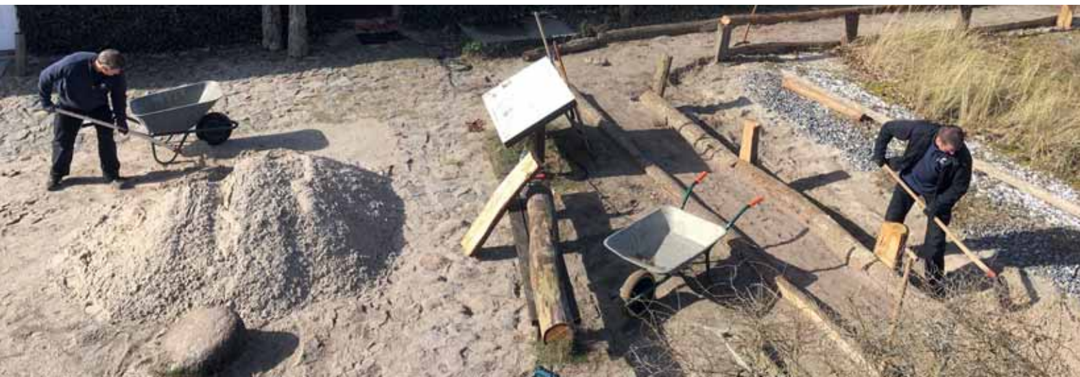
Techniker im Dünengarten: Mit frischem Sand und neuen Balken bereiten Heiko Rohde und Detlef Bittner die Anpflanzung der lebenden Ausstellung von Küstenvegetation vor.
