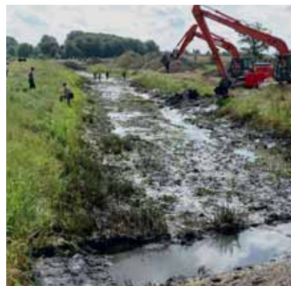
Renaturierungsarbeiten an der Barthe bei Redebas.
