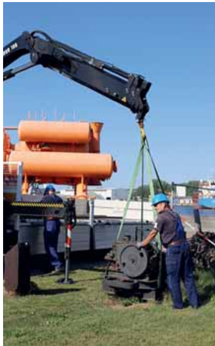
Ein historisches Schienenfahrzeug für den Deichbau wird verladen. Die aufwendige Rekonstruktion erfolgt in den Werkstätten der SIC.
